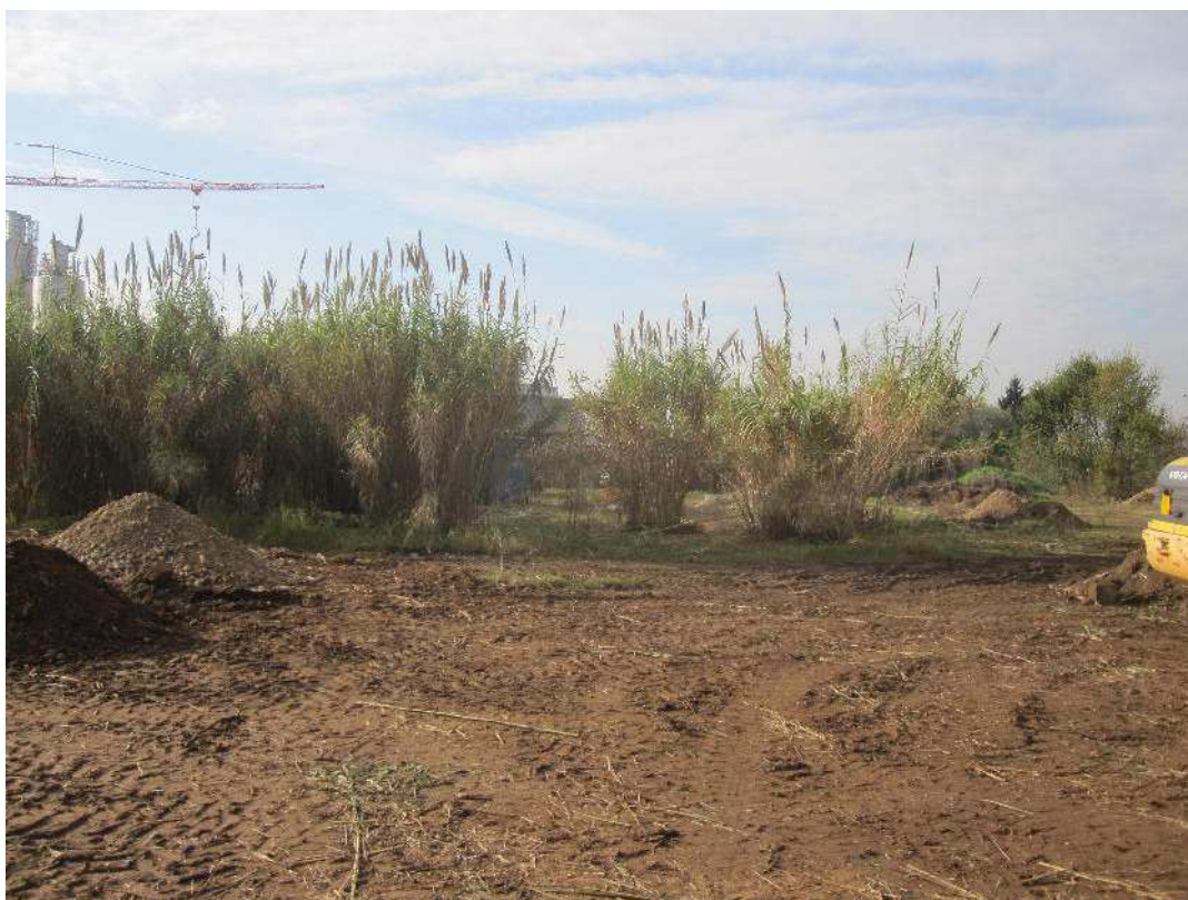
Area di indagine vista da ovest
